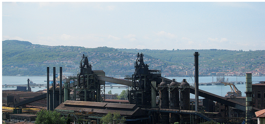
FIGURA 2 Impianti siderurgici di Servola, Trieste; si notino i due altiforni e, a destra, i grandi cilindri delle torri Cowper.
