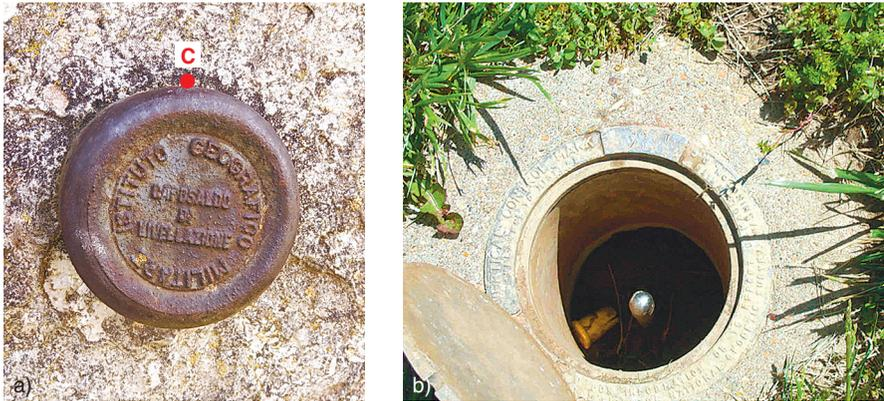
**FIGURA 24** Esempi di segnali per capisaldi di livellazione: a) di tipo verticale murato a parete (il punto C costituisce il riferimento del caposaldo), b) di tipo orizzontale protetto da chiusino in ghisa.
