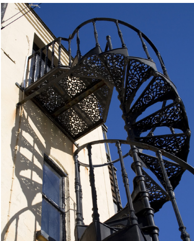
■ Una scala interamente realizzata in ghisa.
