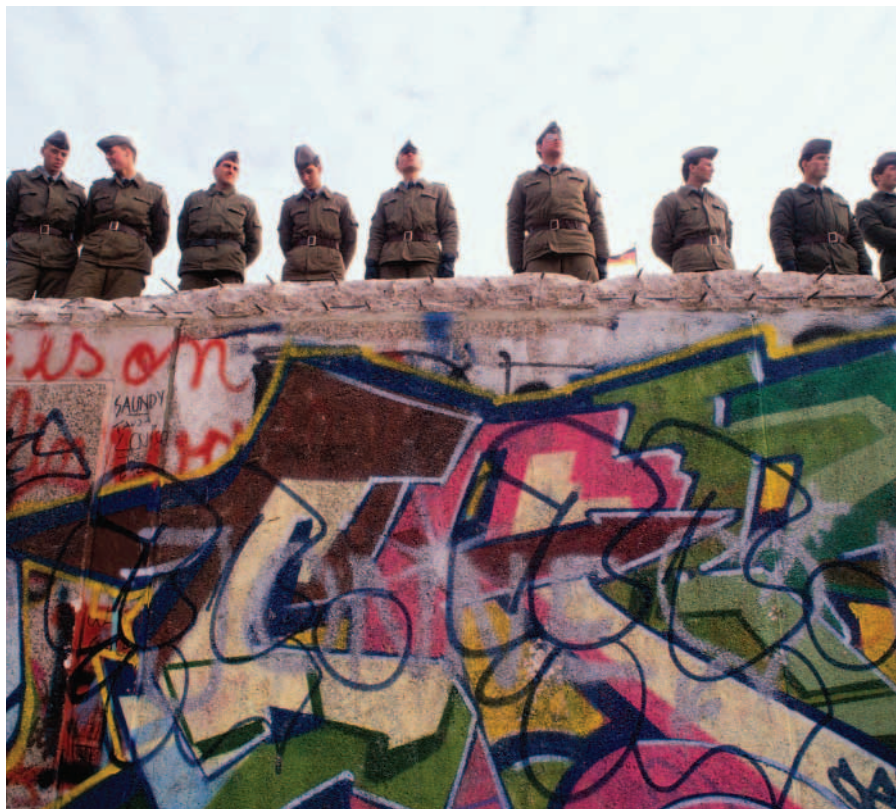
Figura 1 Le guardie di frontiera di Berlino est osservano incredule l'inizio ufficiale della demolizione del Muro, il 10 novembre 1989.
