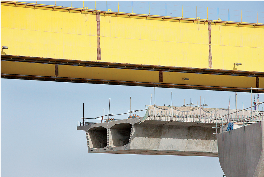
FIGURA 9 Impalcato precompresso da ponte.
