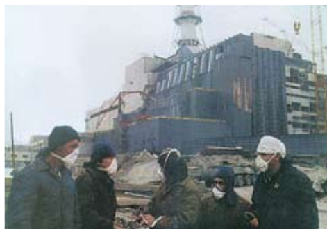
Costruzione del "sarcofago".
