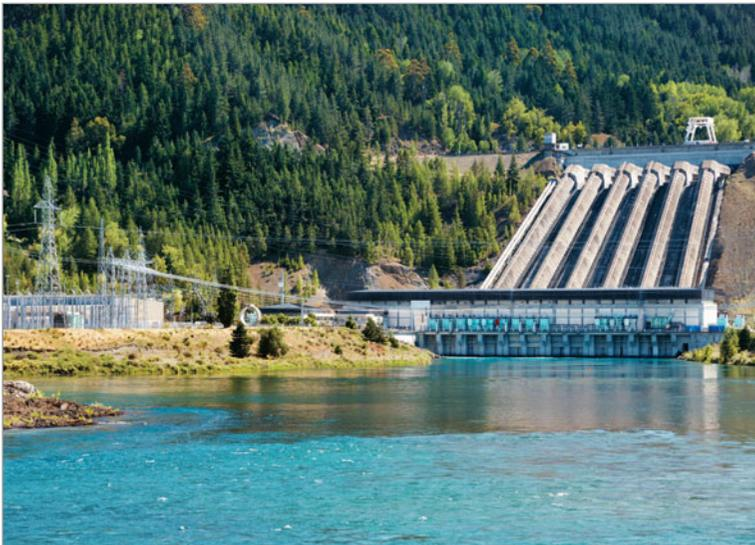
A questa è collegata un'altra macchina, chiamata alternatore, che trasforma in energia elettrica l'energia di movimento delle pale. Maggiore è la quantità d'acqua che arriva, maggiore è la velocità con cui gira la ruota della turbina. Quindi, più acqua scorre nelle condutture, maggiore è l'energia prodotta nell'impianto.
