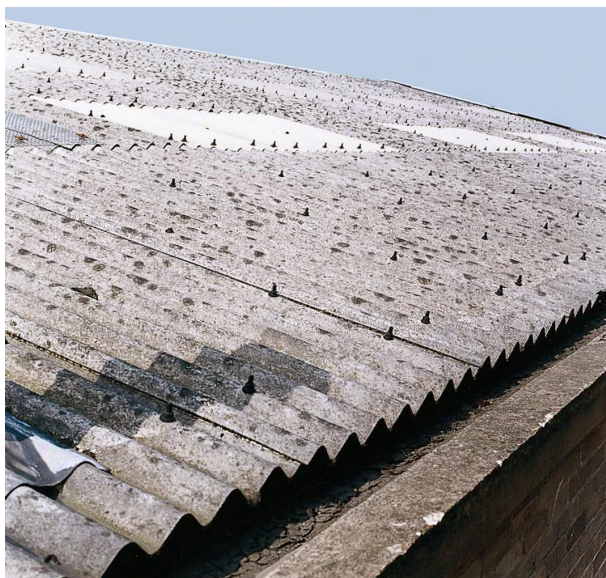
FIGURA 2 Lastre di copertura dei tetti in amianto.
