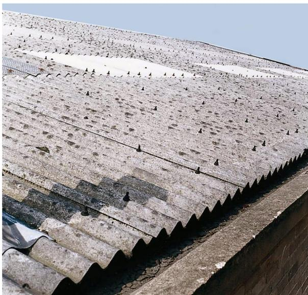
**FIGURA 2** Lastre di copertura dei tetti in amianto.
