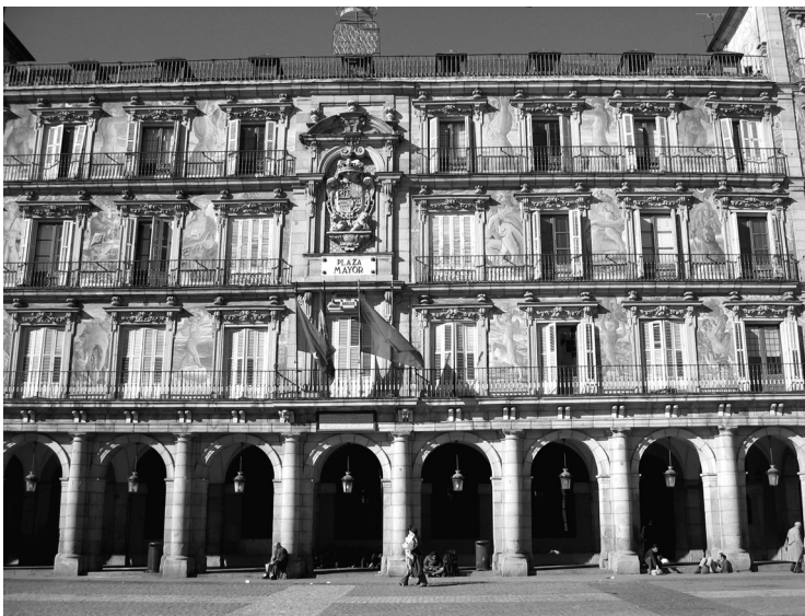
Casa de la Panadería.
