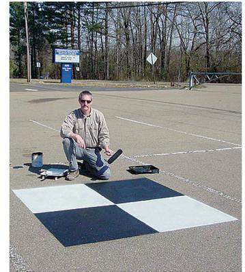
**FIGURA 15** Segnalazione di un punto di appoggio artificiale a terra per l'operazione di orientamento assoluto dei fotogrammi. Dimensioni, forma e colori sono scelti in funzione del loro facile riconoscimento sui fotogrammi tenendo conto della loro scala.
