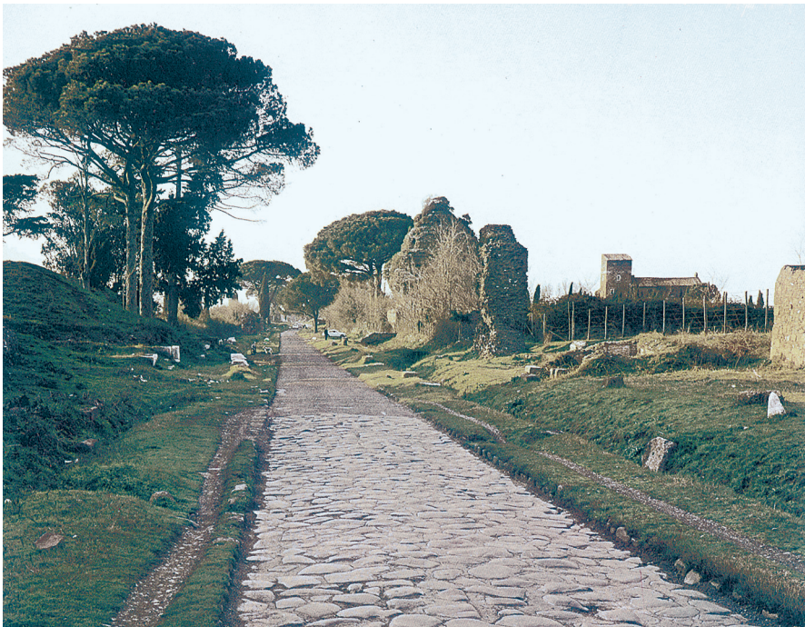
FIGURA 8 La Via Appia è forse la più celebre delle antiche strade romane. Voluta dal censore Appio Claudio nel 312 a.C., questa strada collegava Roma con Capua, Taranto e Brindisi. In alcuni tratti la sua pavimentazione in blocchi di pietra lavica è rimasta pressoché intatta.
