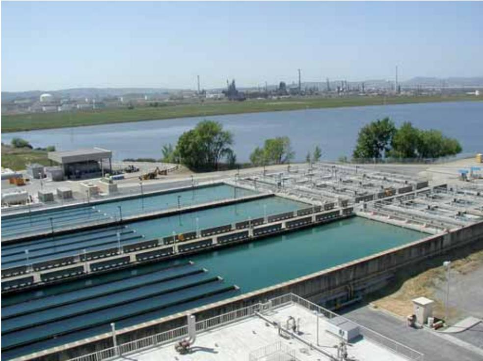
Un impianto di depurazione, nel quale l'acqua sedimenta e vengono aggiunte sostanze addensanti.
