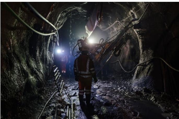
**figura 1** Operaio in miniera. Le alte temperature presenti nel sottosuolo obbligano a prevedere equipaggiamenti particolari e metodi di raffreddamento delle gallerie. La miniera più profonda del mondo si trova vicino a Johannesburg ed è la «TauTona mine», che raggiunge i 3,9 km nel sottosuolo.
