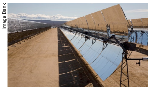
Figg. 3 e 4 Grandi specchi o 'collettori' concentrano la luce solare. Il calore viene usato per trasformare l'acqua in vapore, che muove turbine e produce elettricità.
