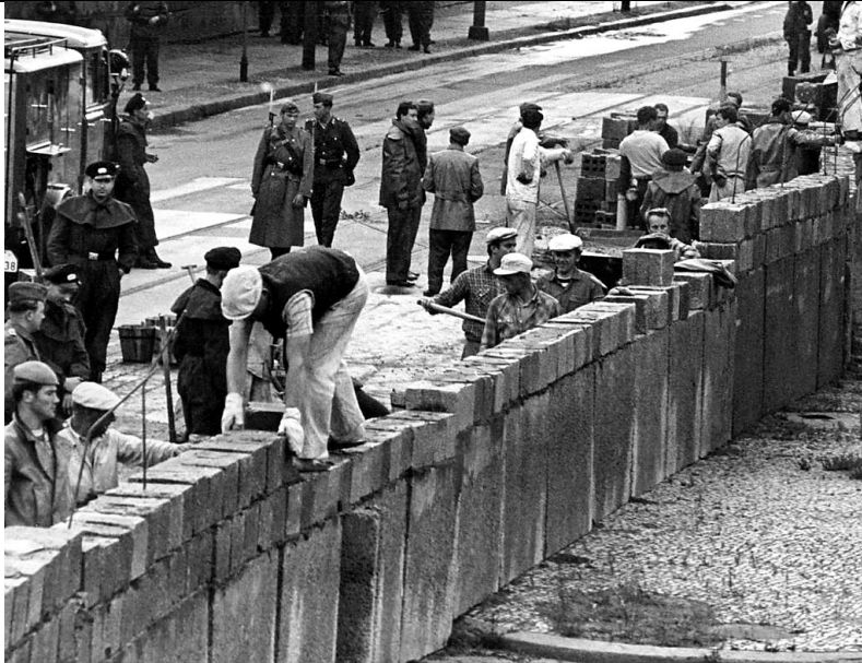
13. August 1961: die Mauer wird gebaut.
