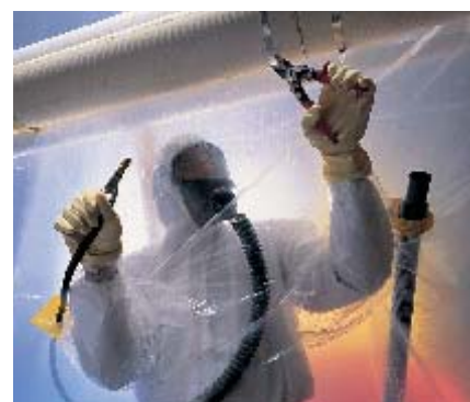
Figura 5 - L'esposizione a sostanze chimiche irritanti rappresenta uno tra i più importanti fattori di rischio per l'insorgenza dei tumori. Per questo, in alcune lavorazioni pericolose vengono prese precauzioni particolari (tute, guanti, mascherine ecc.) per proteggere i lavoratori.
