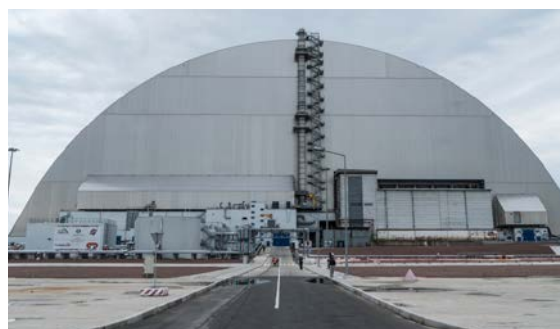
↑ Costruzione del "sarcofago".
