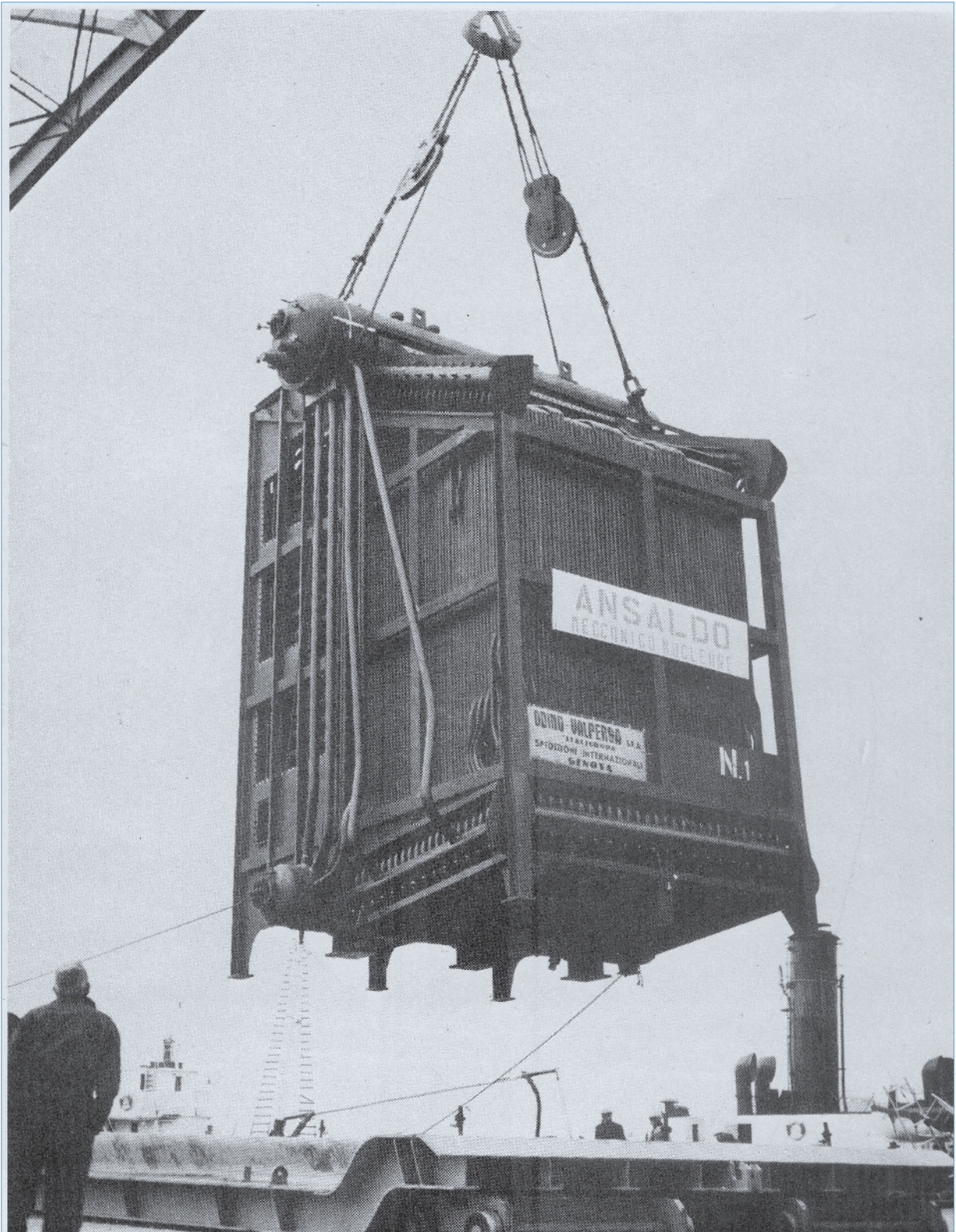
3 Operazioni di imbarco di una caldaia marina tipo Foster-Wheeler adatta per la propulsione navale (Ansaldo M.N. S.p.A. – Genova).
