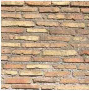
Opus latericium. Classica configurazione per muri resistenti e di aspetto particolarmente decoroso.
