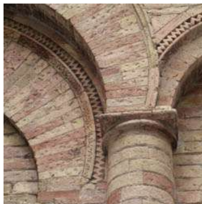
Particolare della Chiesa di S. Jacopo a San Gimignano (XIII secolo).
