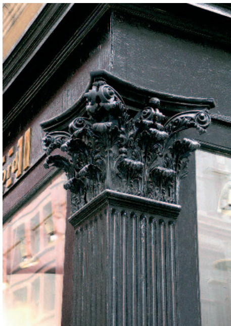
Capitello corinzio in ghisa, New York (XIX sec.). L'uso dei nuovi materiali si estende anche agli edifici, ma non riesce a emanciparsi dagli stili architettonici.
