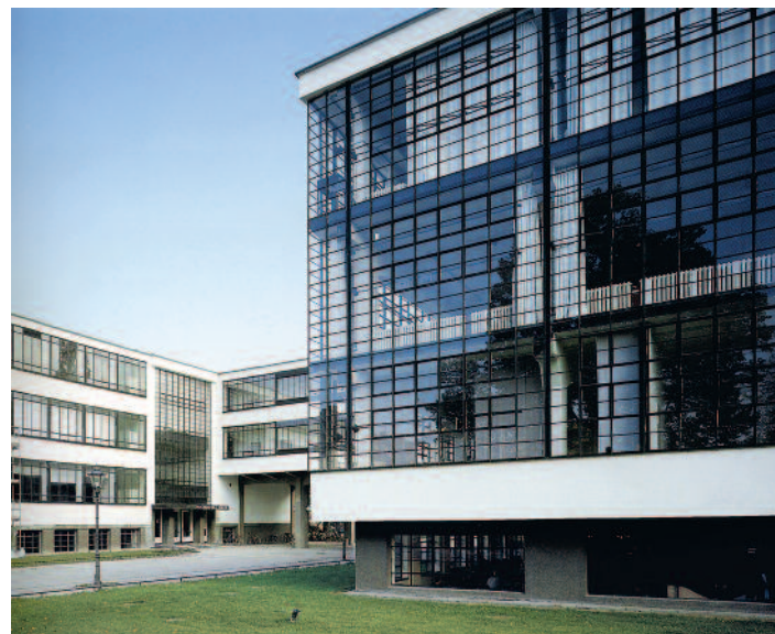
Edificio del Bauhaus a Dessau, di Walter Gropius (1926). Acciaio, cemento armato e vetro sono i materiali privilegiati dalla nuova architettura razionalista.
