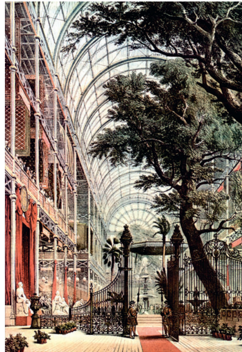
Crystal Palace, a Londra, di Joseph Paxton (1851). Realizzato per la grande Esposizione del 1851 in ghisa e vetro con sistemi altamente industrializzati, ebbe una risonanza mondiale, fornendo ai nuovi materiali dignità architettonica. Le grandi Esposizioni universali dell'Ottocento furono un potente mezzo di pubblicizzazione delle meraviglie della tecnologia moderna [v. nota a fondo pagina].
