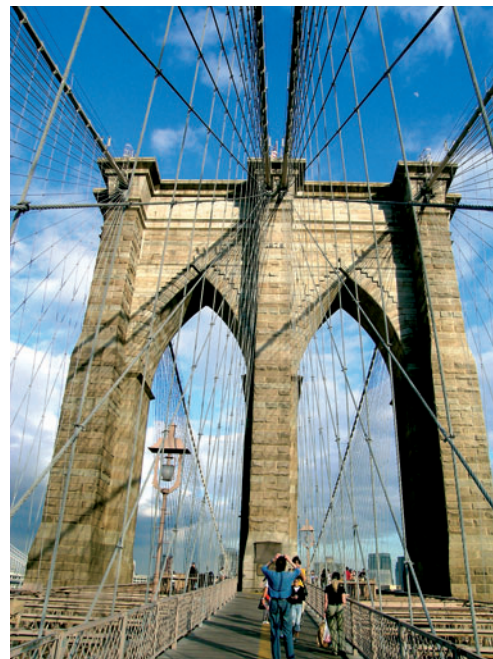
Ponte di Brooklyn, a New York, di John Augustus Roebling (1869-1883). I grandi ponti furono il principale terreno di sperimentazione delle prestazioni dell'acciaio in ambito civile e crearono una diffusa attenzione sociale per i nuovi materiali industriali.
