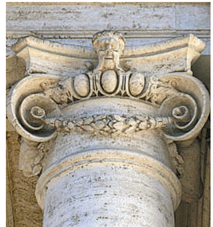
Capitello ionico del palazzo dei Conservatori di Michelangelo (1568); il prototipo classico viene reinventato con elementi fantastici.
