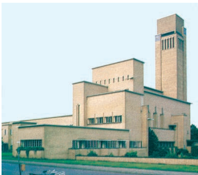
Municipio di Hilversum in Olanda di Willem Marinus Dudok (1924). Esempio di composizione di volumi parallelepipedi che danno una equilibrata geometria all'edificio, secondo i dettami del neoplasticismo.
