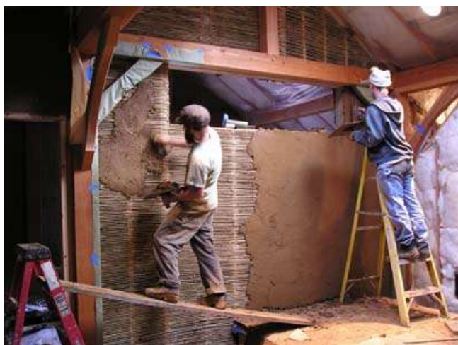
Posa di intonaco naturale su tramezzo a canniccio.
