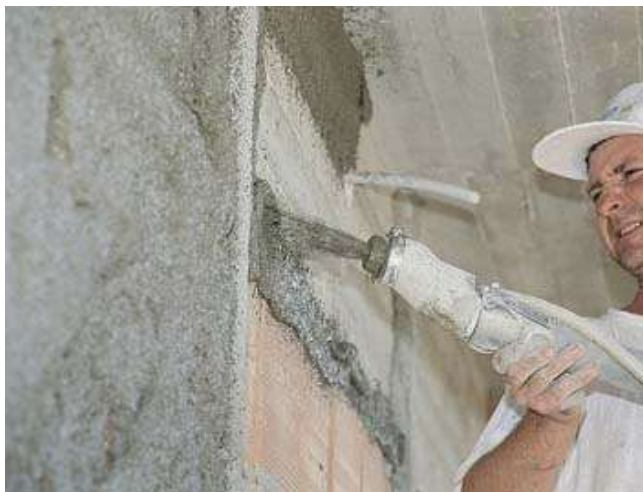
Posa di intonaco naturale isolante a base di sughero e calce idraulica.
