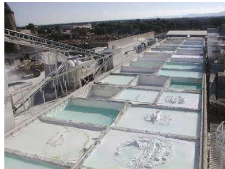
Vasche per la maturazione del grassello.
