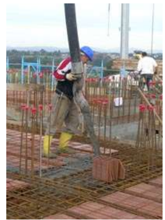
Getto di calcestruzzo.
