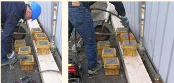
Riempimento delle cubiere. Compattazione con vibratore nelle cubiere.
