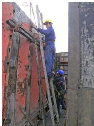
Disarmo di cassaforma di un muro.
