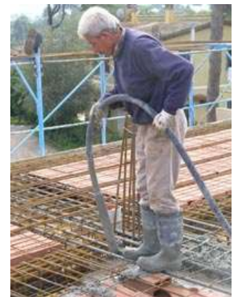
Compattazione del calcestruzzo mediante vibratore.
