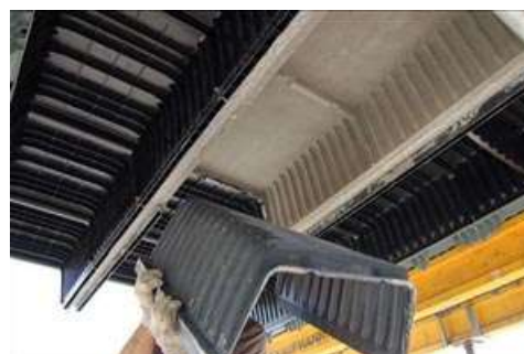
Disarmo di cassaforma di un muro.
