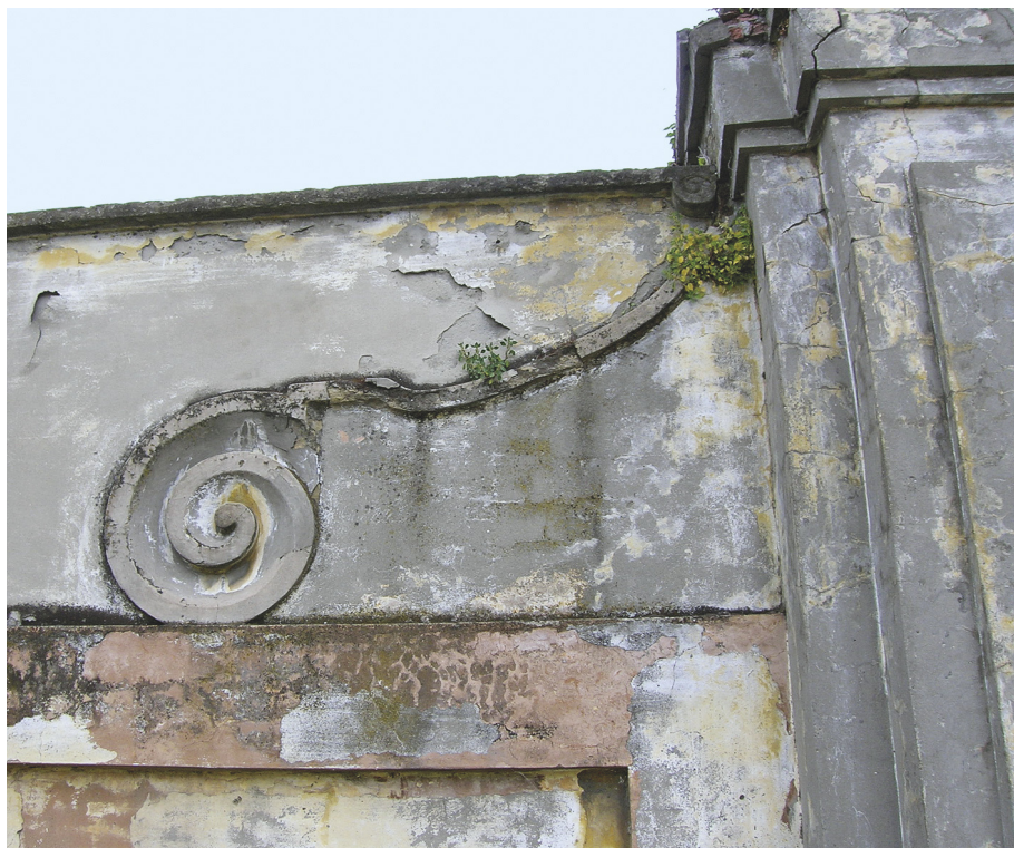
FIGURA 12 Accesso alla Corte: particolare delle volute di pietra che raccordano il muro di cinta agli edifici e ai due pilastri di ingresso.
