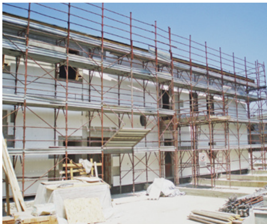
COIBENTAZIONE, INTONACATURA E TINTEGGIATURA DELLE PARETI ESTERNE
