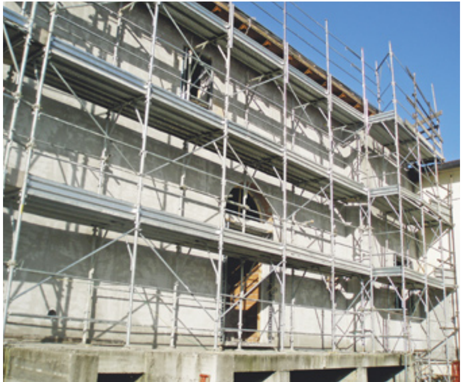
FIGURA 82 Intonacatura della facciata principale della Villa.
