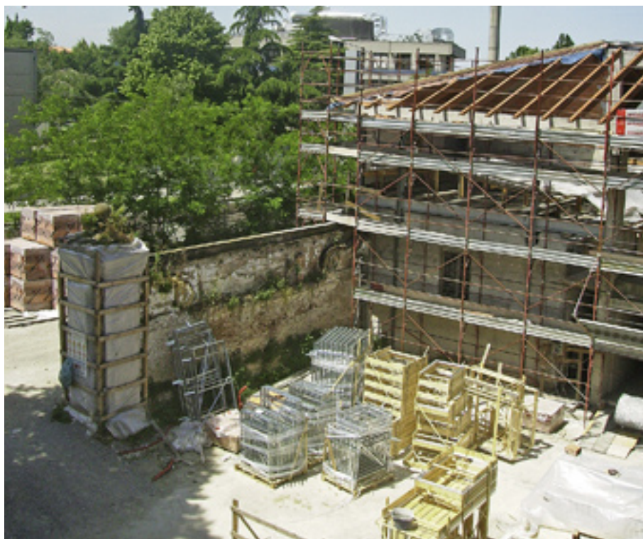
FIGURA 35 Ponteggio del Casale in corrispondenza di via del Gomito.
