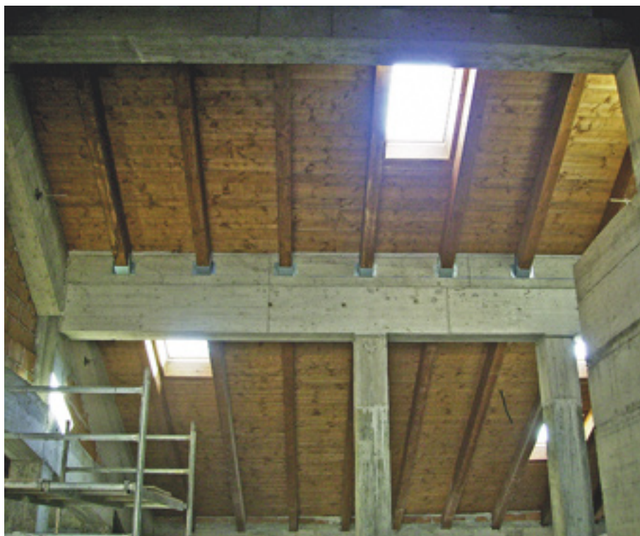
FIGURA 75 Sulle travi in legno è appoggiato il tavolato.
