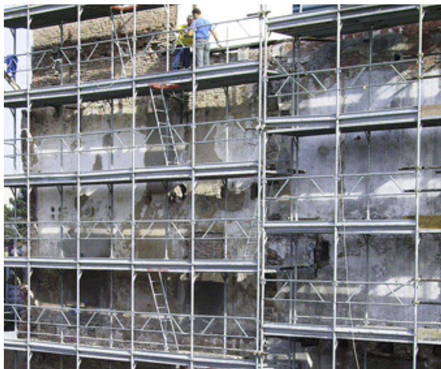
FIGURA 32 Ponteggio della Villa (demolita) in corrispondenza del fabbricato confinante.
