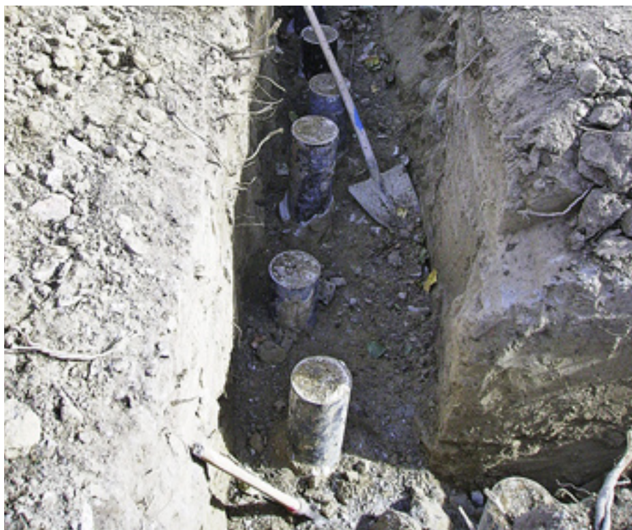
FIGURA 43 Pali della paratia in opera.
