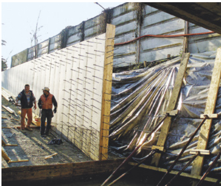
FIGURA 28 Protezione delle pareti laterali con teli impermeabili e sbadacchiature a sostegno dello scavo aperto.
