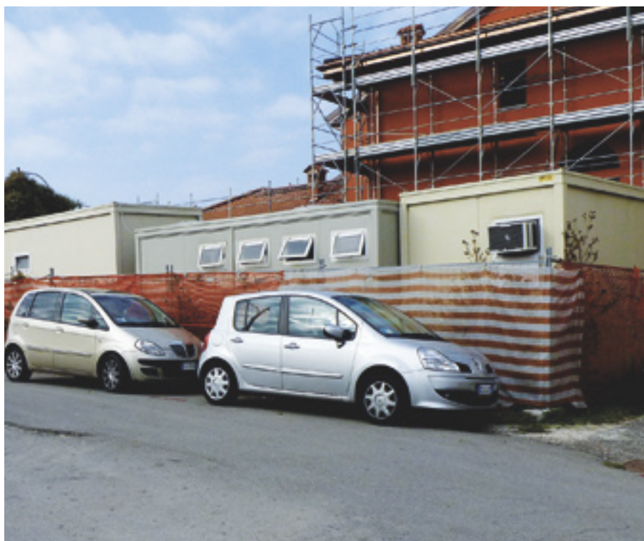
FIGURA 22 Baracche (mensa, wc, spogliatoio, ufficio).
