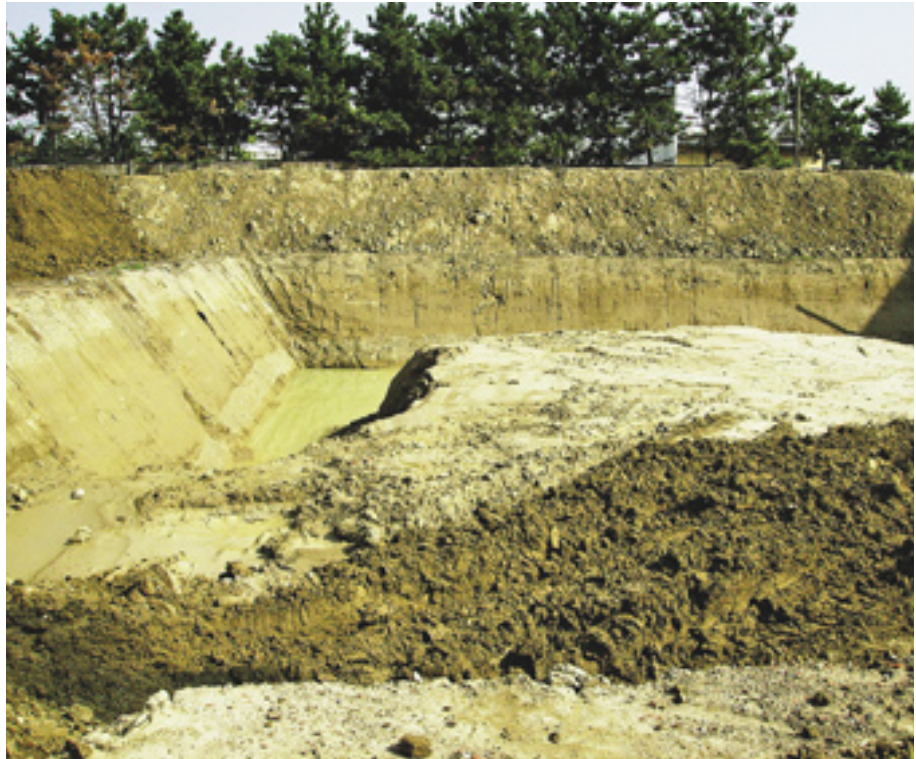
FIGURA 49 Scavo svasato nella zona nord del cantiere.
