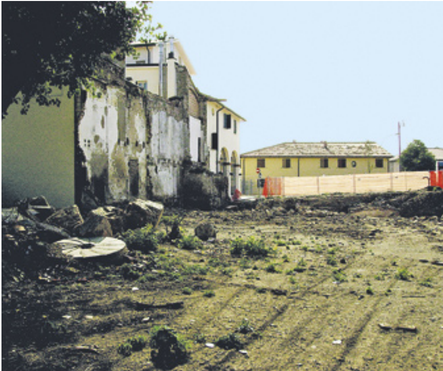
FIGURA 47 L'area in fase di pulizia, dopo le demolizioni.
