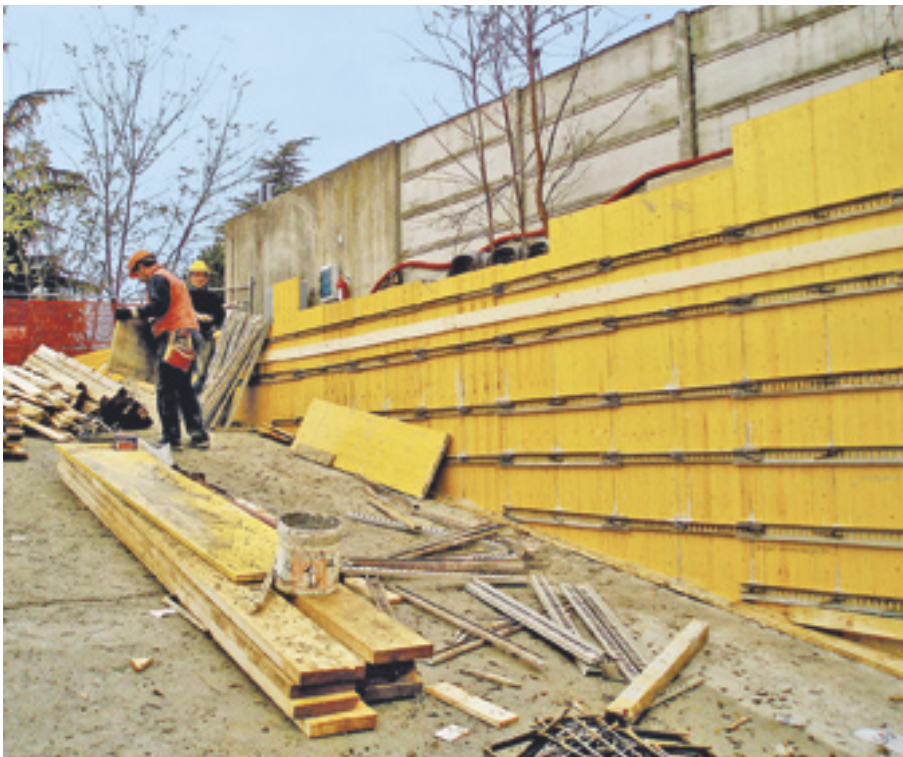
FIGURA 60 Carpenteria del muro della rampa.
