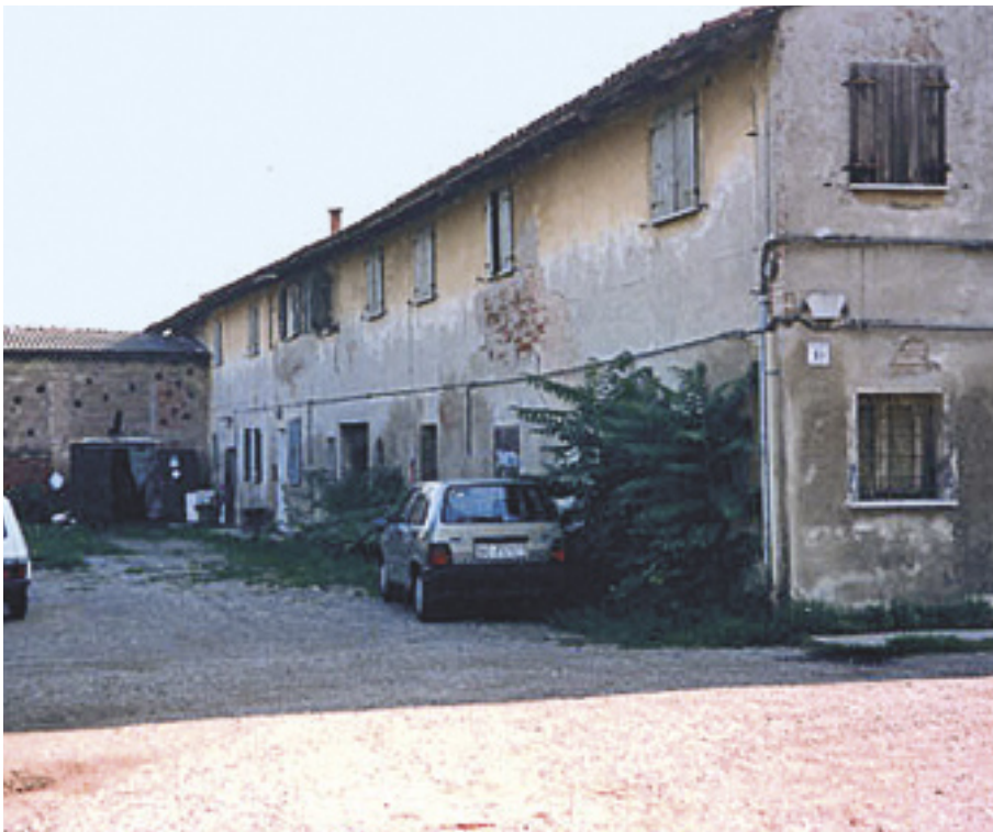
FIGURA 6 Il Casale: fronte nord-ovest.
