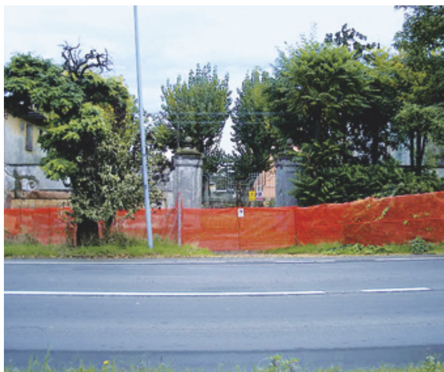
FIGURA 20 Nuova recinzione (su via del Gomito).
