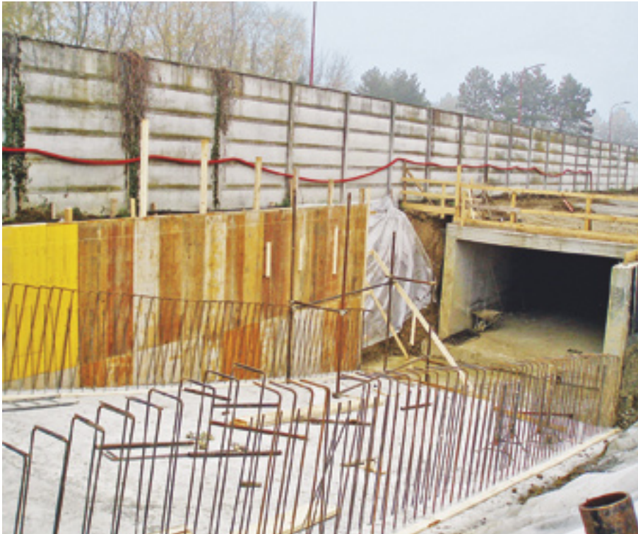
FIGURA 59 Lavori di esecuzione della rampa.
