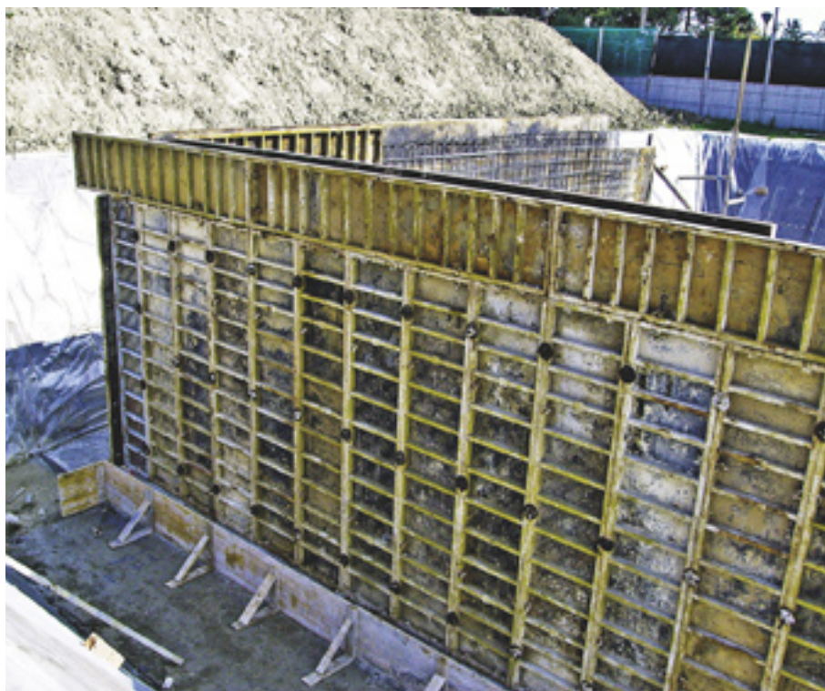
FIGURA 63 Cassaforma metallica e armature dei muri gettati in opera.
