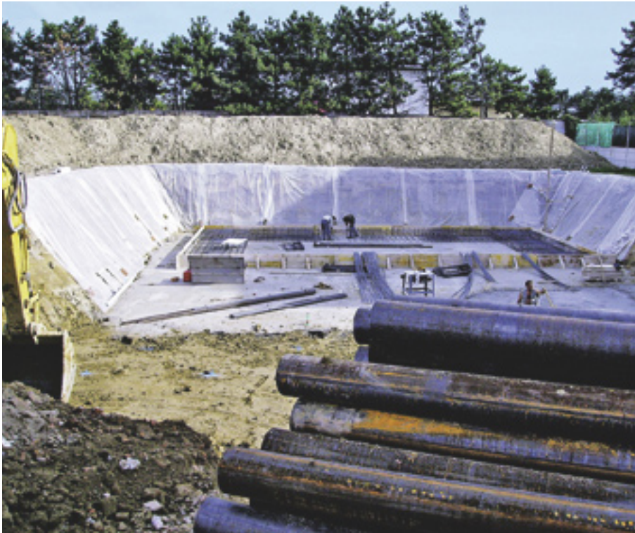
FIGURA 55 La platea in corrispondenza dell'edificio C.
