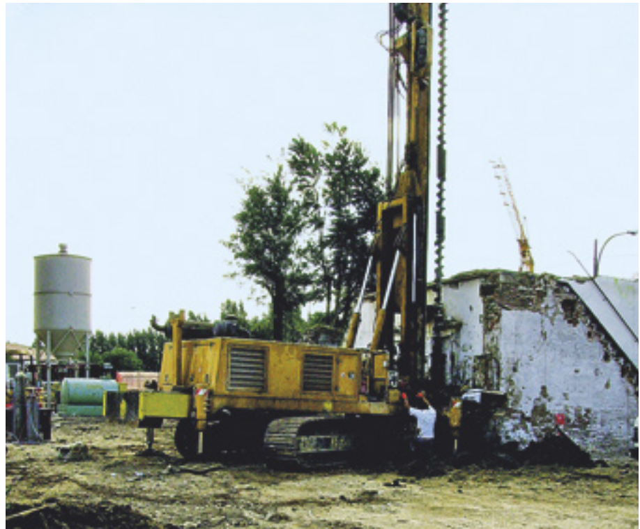
FIGURA 41 Realizzazione della paratia di consolidamento in corrispondenza del muro dell'Oratorio.
