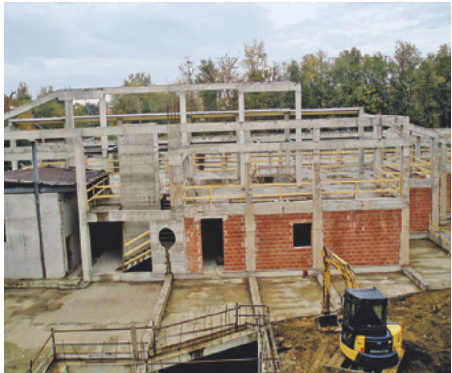
FIGURA 66 Pilastrini e travi del Casale.
