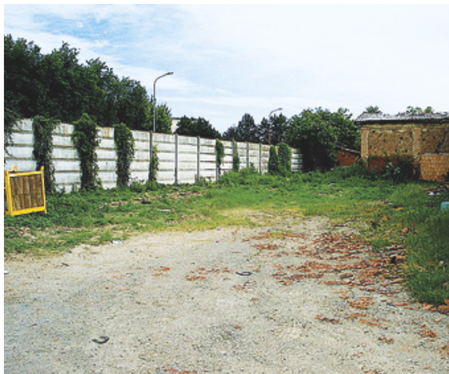
FIGURA 19 Recinzione esistente (lato nord-ovest).
