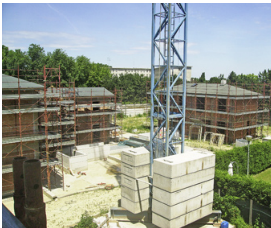
FIGURA 36 Ponteggio del Casale e dell'Edificio C.
