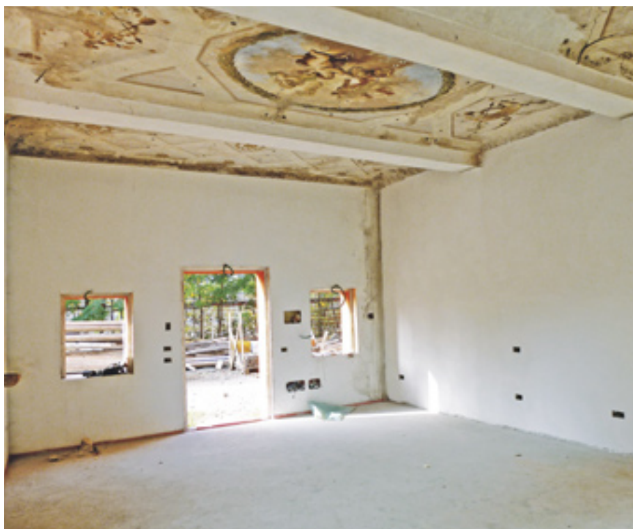
FIGURA 14 L'Oratorio durante i lavori di restauro.
