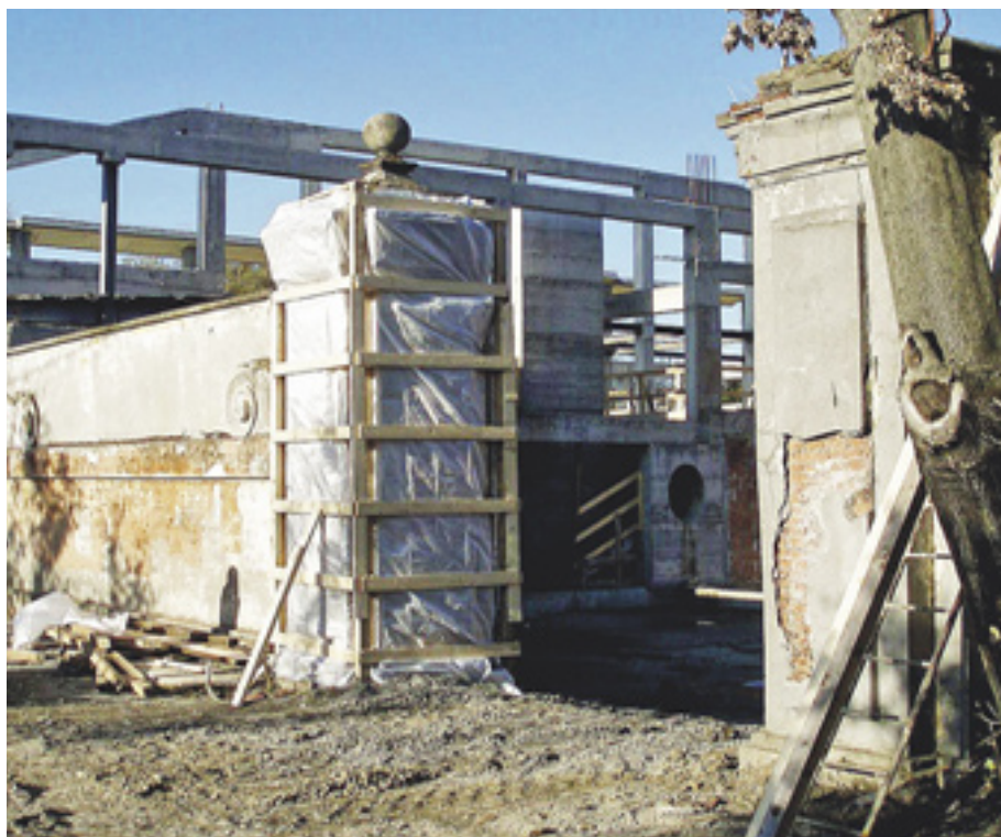
FIGURA 13 Protezione dei due pilastri storici dell'accesso da via del Gomito.
