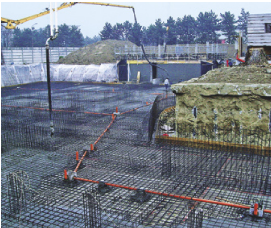
FIGURA 52 Dalla platea emergono i ferri per la ripresa delle armature dei pilastri e dei muri superiori in CA; si notino le tubazioni fognarie, predisposte prima del getto.
