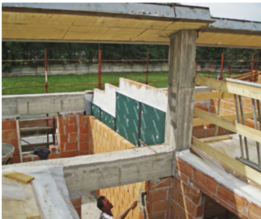
FIGURA 76 Esecuzione di un tamponamento a doppia parete, con strati isolanti interposti.
