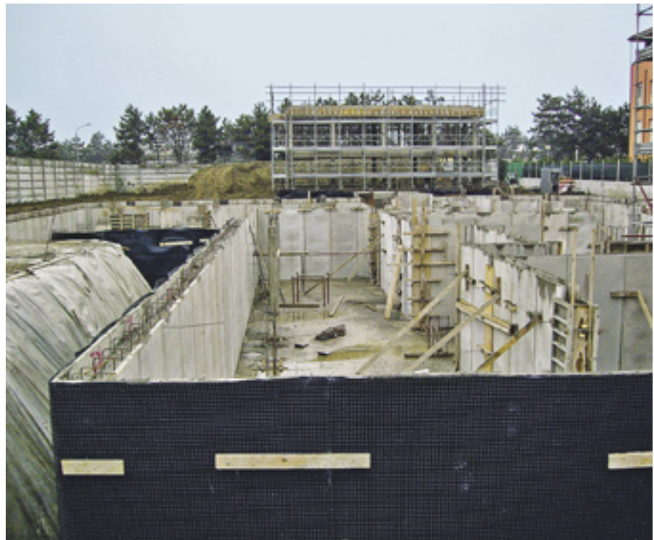
FIGURA 62 Muri prefabbricati, con casseforme a perdere, e pilastri; si noti l'impermeabilizzazione applicata ai paramenti contro terra dei muri stessi.
