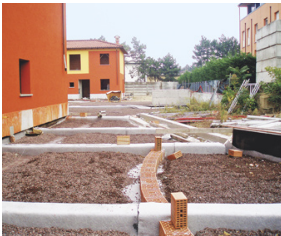
FIGURA 92 Sistemazione esterna dell'area adiacente al Casale; si notino le travi del piano interrato, fasciate di tessuto non tessuto.
