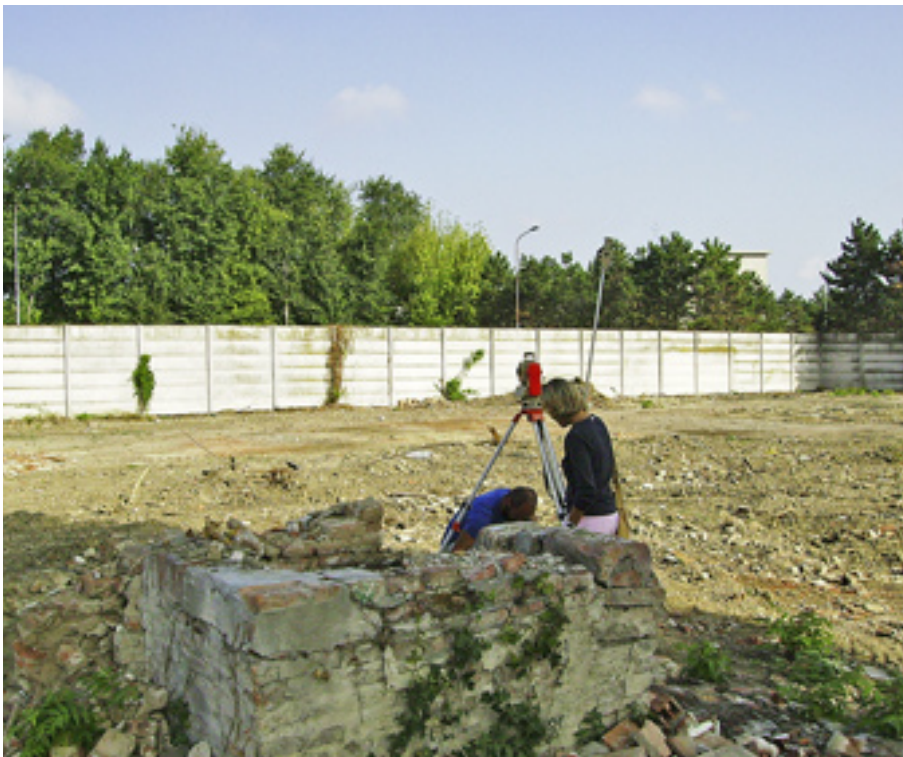
FIGURA 48 Operazioni di tracciamento prima dell'inizio degli scavi.
