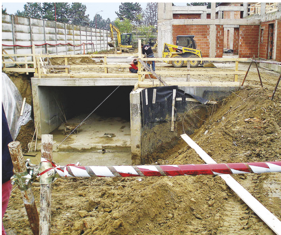
FIGURA 27 Scavo per l'accesso al parcheggio interrato.
