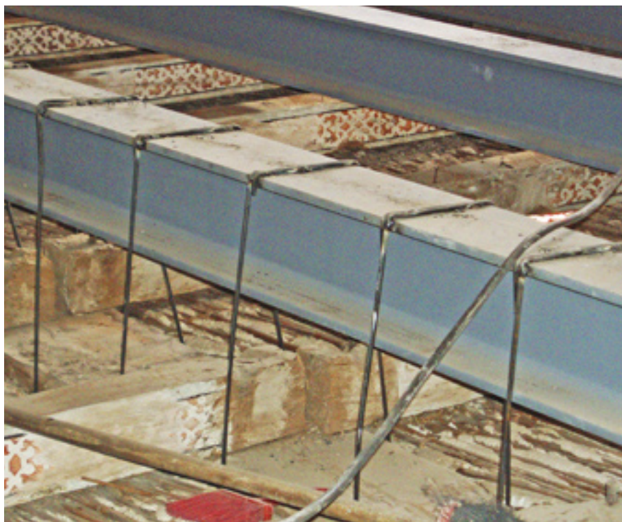
FIGURA 39 Estradosso del solaio dell'Oratorio; le travi esistenti sono appese con staffe metalliche alle putrelle di rinforzo.
