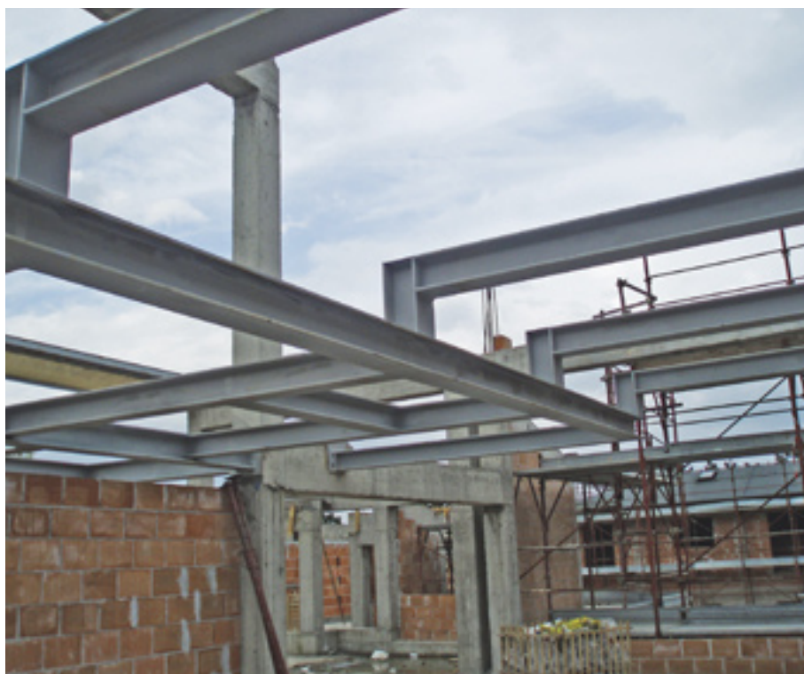
FIGURA 68 Le putrelle (profilati tipo HE) sono gli elementi strutturali principali dei soppalchi interni alle unità abitative.
