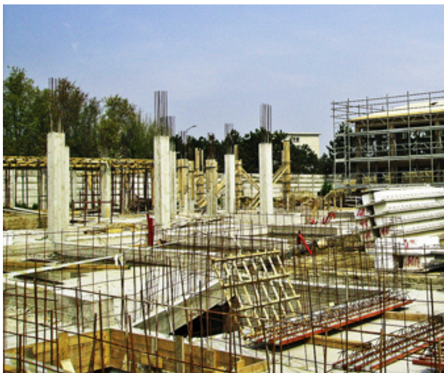
FIGURA 64 Pilastri del piano terreno; si notino i ferri di ripresa per le armature dei pilastri del piano superiore.
