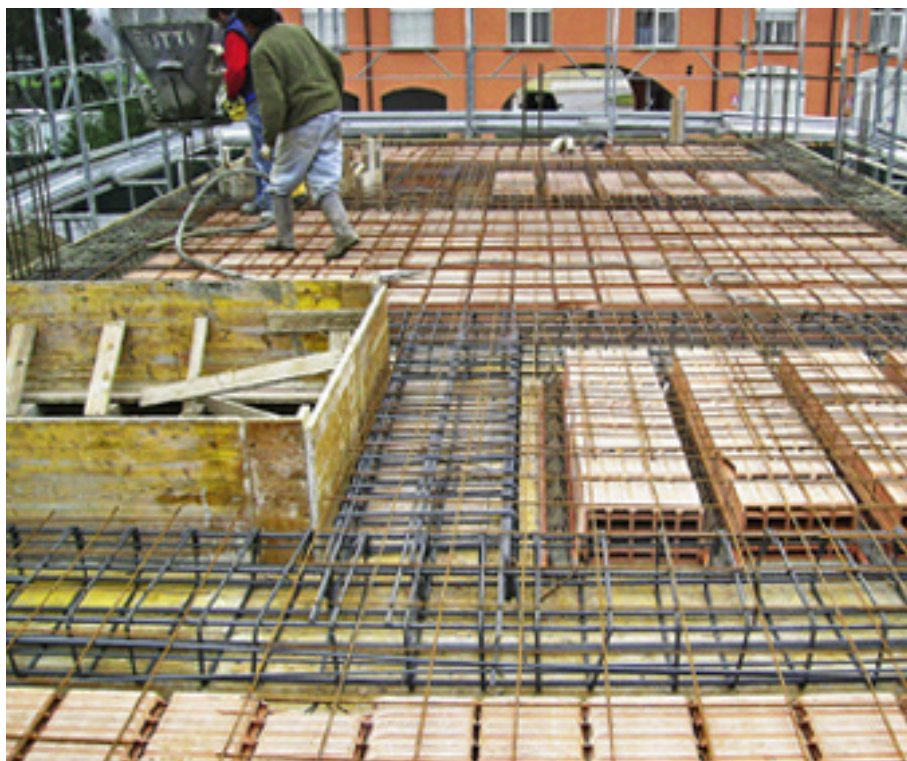
FIGURA 67 Solaio pronto per il getto: si possono vedere le armature delle travi, i travetti tralicciati e i blocchi in laterizio.
