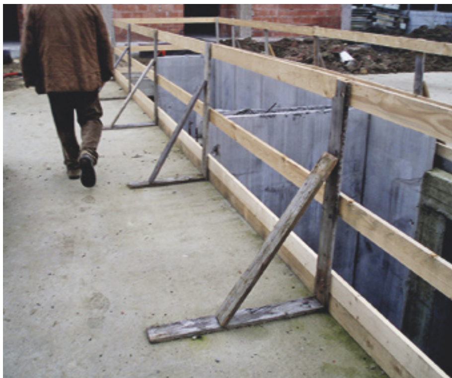
FIGURA 29 Lungo parapetto con l'indispensabile contrasto antiribaltamento.
