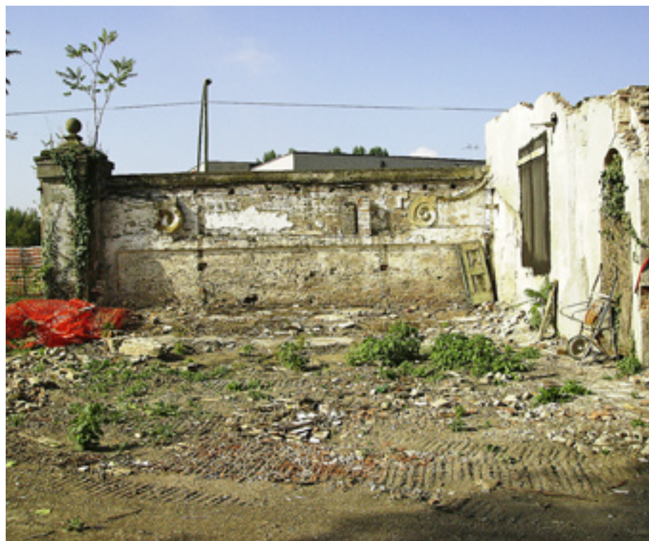
FIGURA 37 La recinzione conservata vista dall'interno del cantiere.
