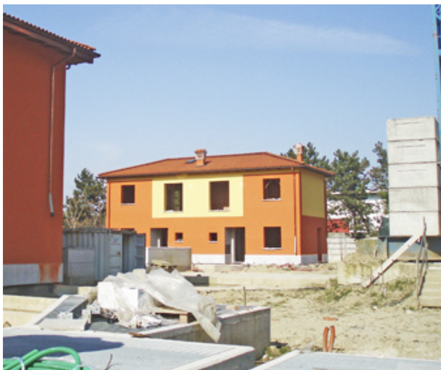
FIGURA 84 Tinteggiatura esterna dell'Edificio C.
