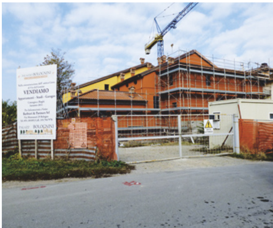
FIGURA 21 Accesso sud-est al cantiere.
