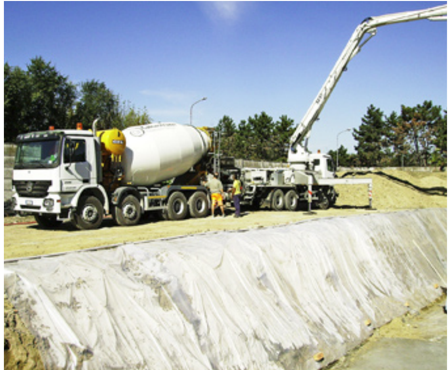
FIGURA 57 È arrivata l'autobetoniera.
